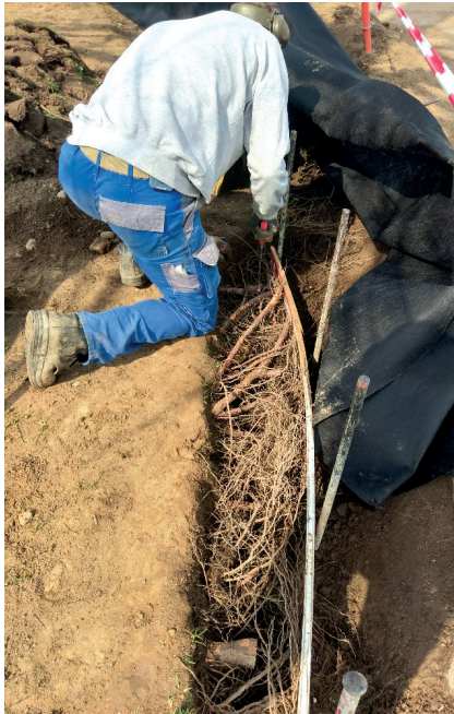
Der Wurzelspezialist an der Arbeit: Sorgfältiger Einbau des Wurzelvorhangs.
